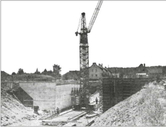
Für die Ortsumgehung der B243 wurde 1973 die Brücke gebaut, die über die Straße „Am Schiefen Berg“ führt.
