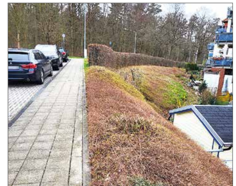
Der steile Hang zum Hof des Nachbargrundstückes rechts ist nicht geschützt.
